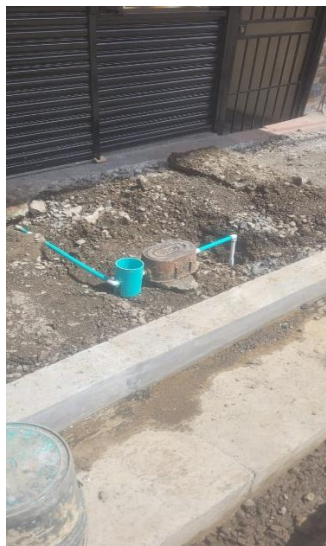
Reubicación de medidores, sector San Rafael Nuevo Puente, por el Balneario
