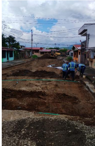
Campabadal, reubicación de tubería
