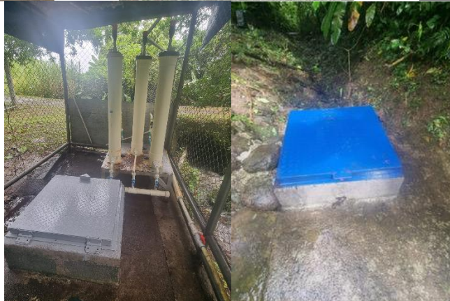
Cambio de tapas en los tanques de captación y almacenamiento
